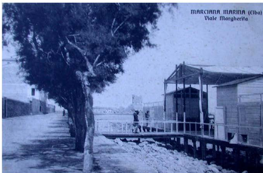
Fig. 5 – Anni Trenta del XX secolo: seconda fase dei “Bagnetti di Cleofe” lungo il viale Regina Margherita. Fra la sede stradale e le palificazioni si nota una piattaforma composta da massi giustapposti e stratificati, che si estendeva grosso modo tra l’attuale pedana del Circolo della Vela e l’estremità orientale dell’odierna Piazza Bonanno.
